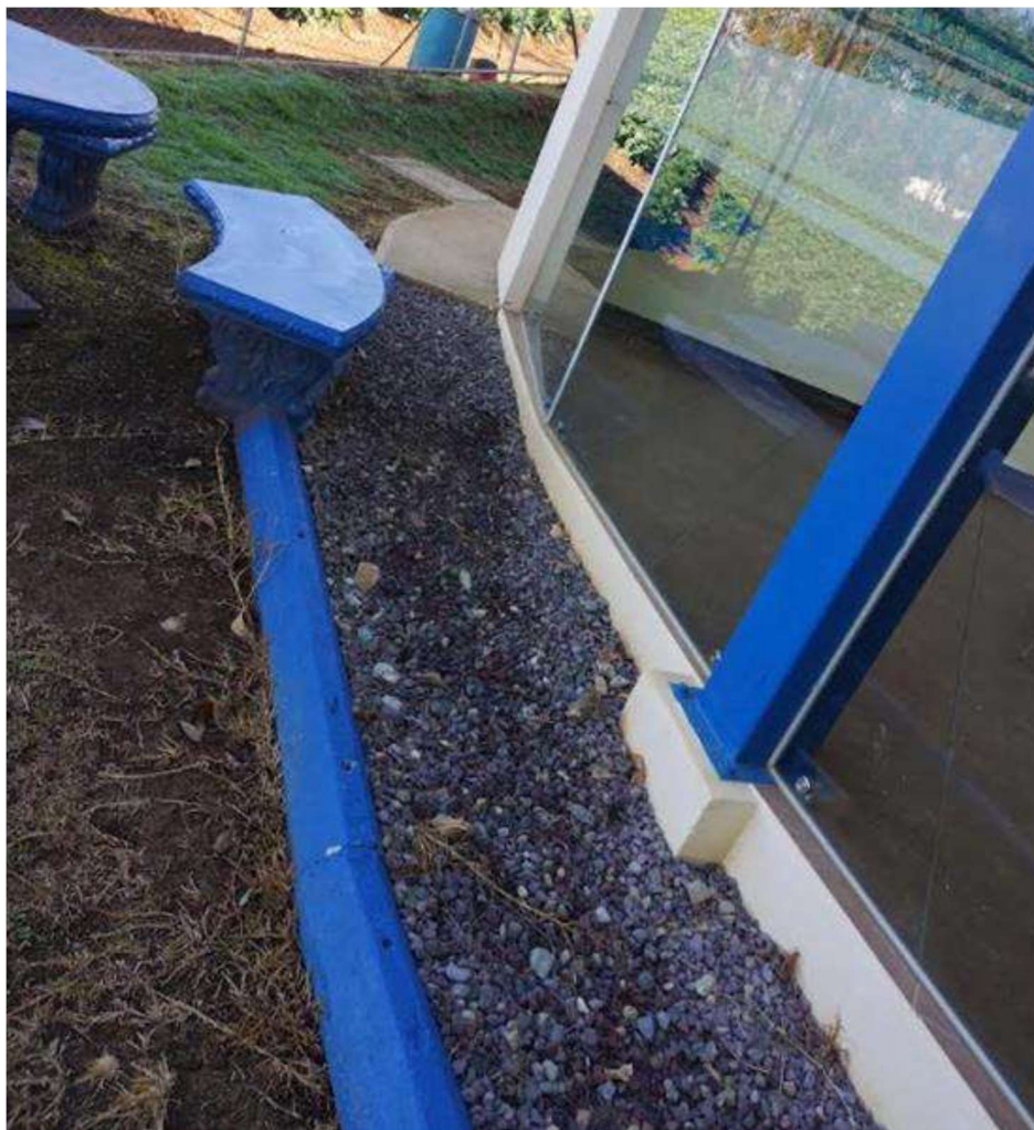
Imagen 10. Colado de acera del salón
