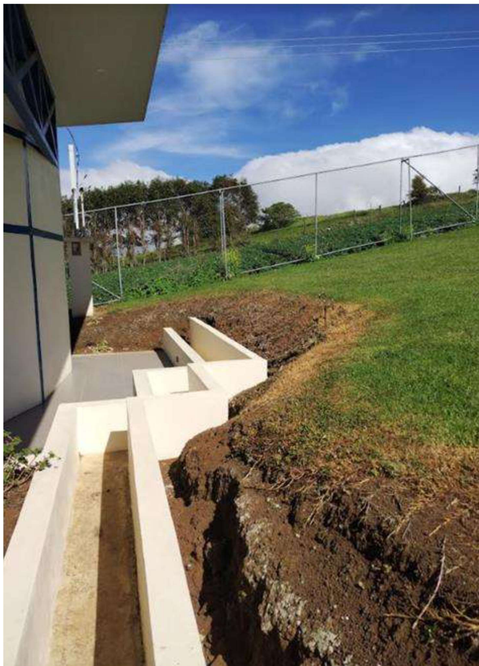
Imagen 5. Zona de relleno de parapeto
