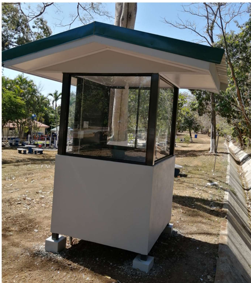
Imagen 28. Detalle caseta terminada.
