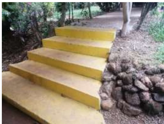
Fig # 8. Antiguo acceso entre salón y servicio sanitario.
