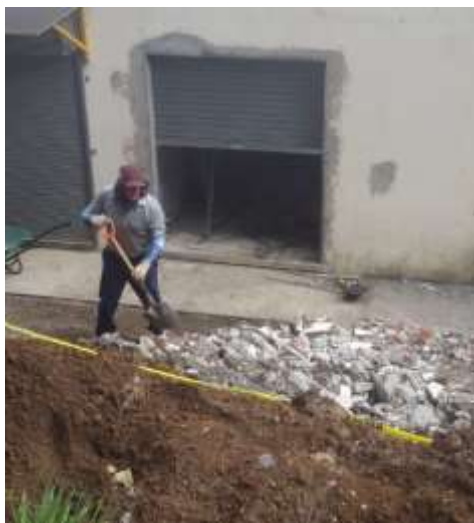
Fig # 27. Acceso a nueva bodega contiguo a cocina restaurante CCR Alajuela.”
