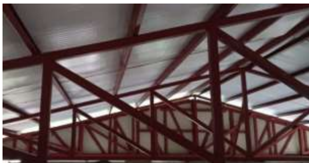
Fig # 13. Nuevas estructuras de techos de cabinas y vestidores.
