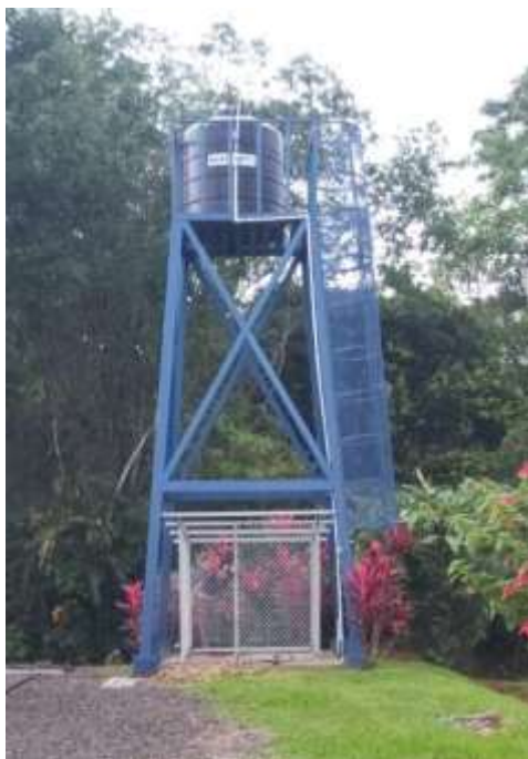
Fig # 3. Mantenimiento de tanque de captación y caseta de sistema de presión constante.
