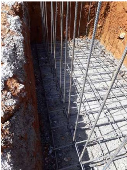
Fig # 10. Estructuración de muros de retención.
