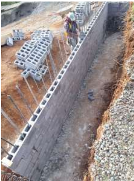
Fig # 11. Construcción de muros de retención.
