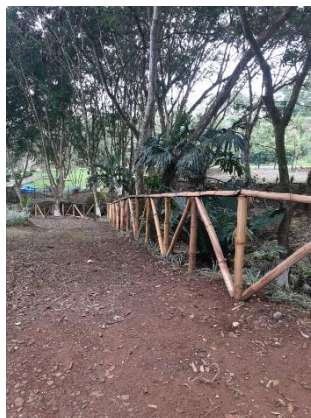
Fig #1. Cerca fabricada con culmos de bambú obtenidas de la finca de Colypro en la entrada de Turrialba.
