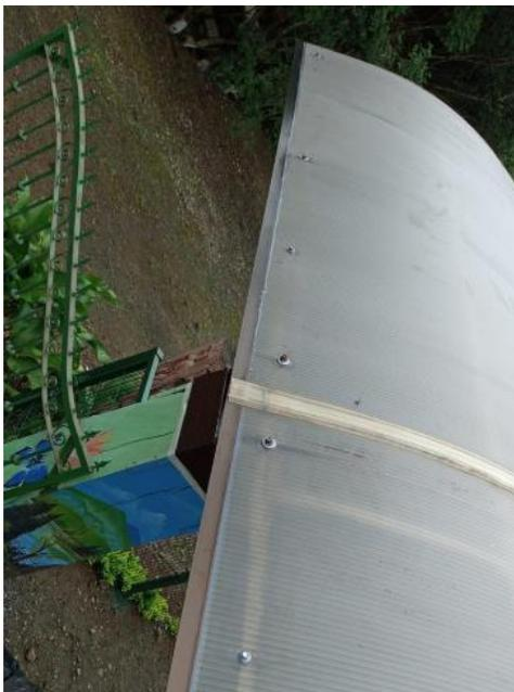
Fotografía #5. Perfiles sustituidos en cubierta de techo y alineamiento de cubierta.
