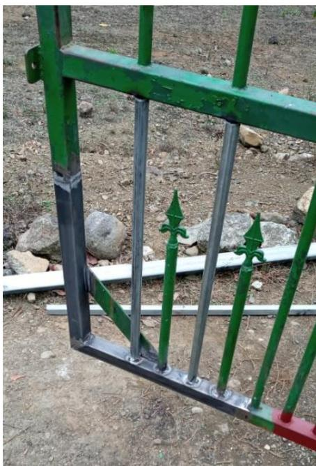
Fotografía #11. Sustitución de piezas dañadas del portón.
