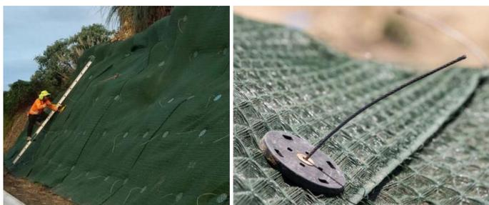
Fotografía #2. Sistema Mirafi® TM13C y TM14S Colocado en el talud que se desea reforzar. Debido a que la geomanta es porosa, la vegetación sale entre los intersticios y eventualmente cubre el talud, creándose una solución de rápida colocación y con cobertura natural.
