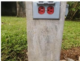
8 Fotografía #2: Detalle de tomacorrientes tipo "grado hospitalario" instalados.
