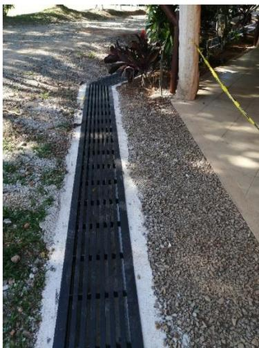
Fotografía #4: Detalle de cuneta de aguas pluviales alrededor del salón.
