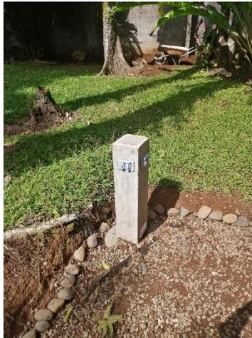
1 Fotografía #1: Colocación de pedestales de concreto con alimentación eléctrica. Total 20 unidades
