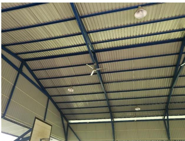
Fotografía #2: Limpieza de estructura y colocación de láminas nuevas en salón.
