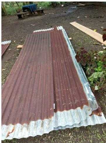
Fotografía #1: Estado de corrosión de las láminas de techo. Láminas en proceso de desmontaje.
