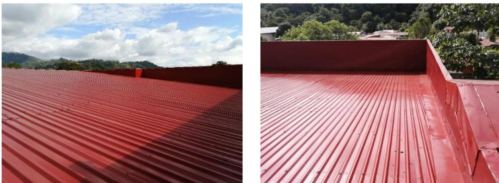
Fotografía # 6. Lavado, sellado y pintura de superficie de techo y tapicheles.
