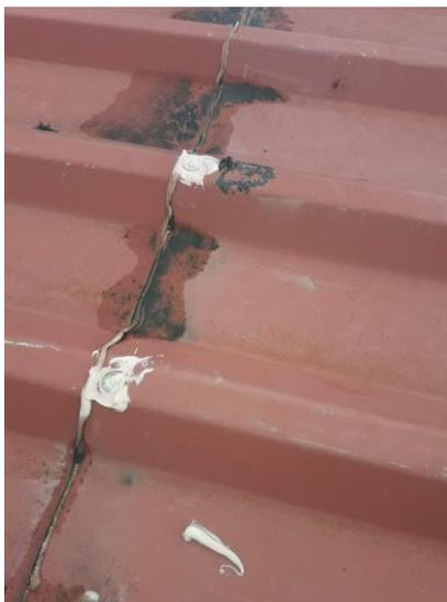
Fotografía # 5. Filtraciones en uniones y bordes del techo.
