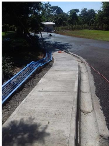
Fotografía # 8. Cuneta y rejillas pluviales.
