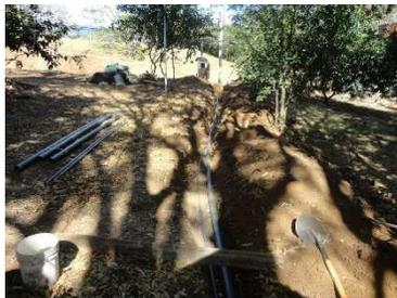
Fotografía # 8. Canalización eléctrica desde acometida hasta caseta de bombeo.
