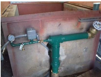
9                    Fotografía # 4. Múltiple (manifold), con válvula de control y manómetro.
