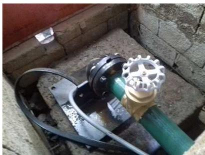
1                    Fotografía # 3. Acople y válvula en tope del pozo (el sistema de motor
