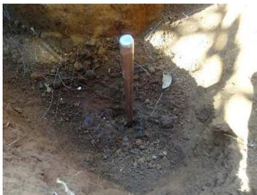
Fotografía # 9. Varillas Cooperweld del sistema de puesta a tierra.
