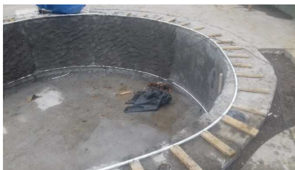
Fotografía # 21. Repello de paredes en piscina de adultos.
