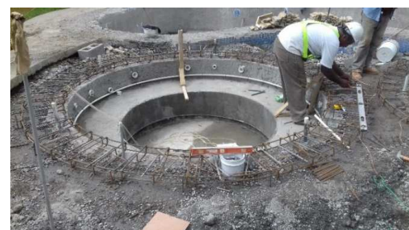
Fotografía # 13. Colocación de previstas electromecánicas de nuevos jacuzzis.
