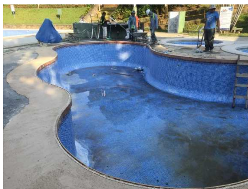
Fotografía # 23. Recolocación de vitrocerámica en piscina de adultos.
