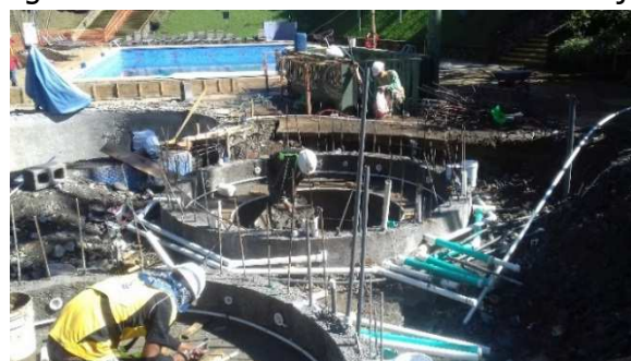
Fotografía # 13. Colocación de previstas electromecánicas de nuevos jacuzzis.
