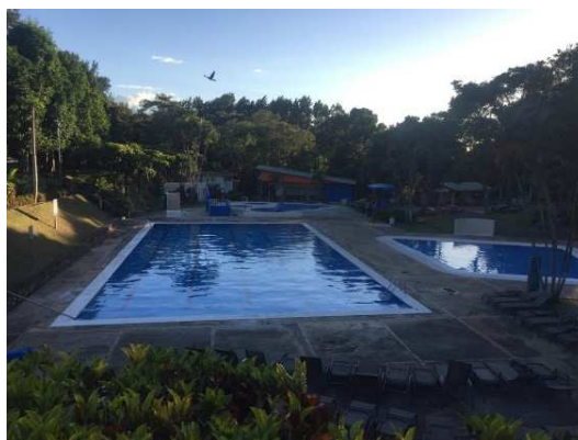
Fotografía # 29. Piscina semiolímpica luego de reparaciones, limpieza de vitrocerámica y resanado de borde perimetral.
