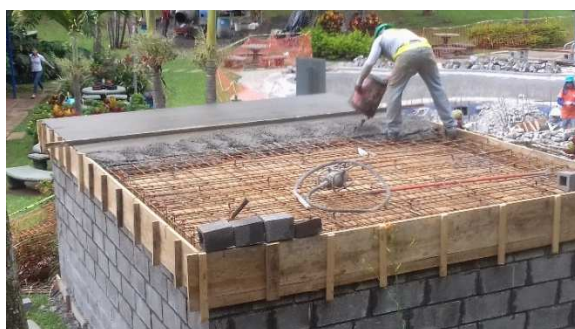
Fotografía # 3. Colado de la losa de techo.
