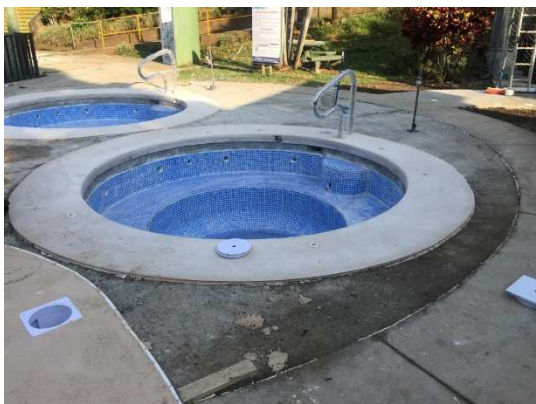
Fotografía # 17. Colocación de vitrocerámica en nuevos jacuzzis.
