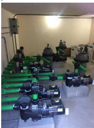
Fotografía # 8. Bombas de recirculación y filtros.
