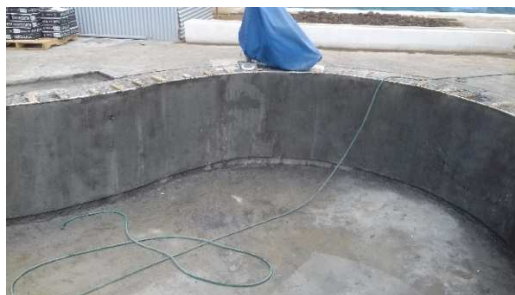
Fotografía # 22. Afinado de paredes en piscina de adultos.
