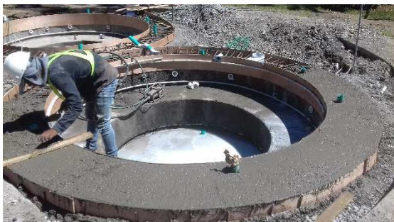
Fotografía # 15. Colado de viga de borde de nuevos jacuzzis.
