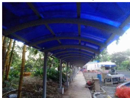
Fotografía #7. Paso techado desde parqueo hasta gimnasio del CCR Alajuela.
