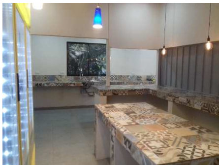
Fotografía # 5. Readecuación de área interna para preparación de alimentos.
