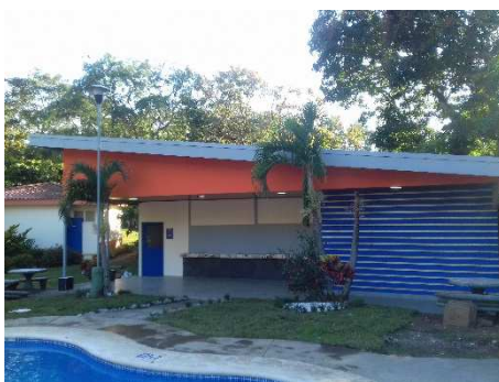
Fotografía #6. Incorporación de elementos arquitectónicos para cambio de imagen.
