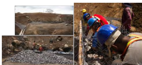
MURO DE GAVIONES EN LAGUNA, HACIENDA ESPAVEL / CLIENTE: DESARROLLOS MEGA / 2015
