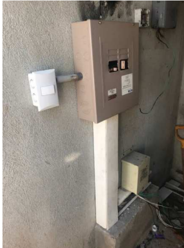
Sustitución de Tablero.
