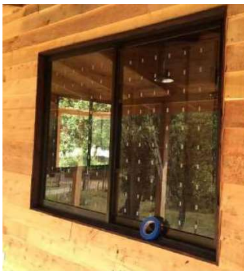
26 Fig#7. Alternativa con películas anti impacto de aves.
